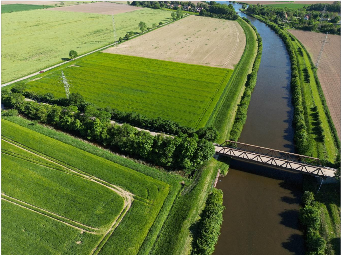
Abbildung 3 Blick auf den Graben, den sog. Kanal, nordöstlich der Brücke Nr. 54.
