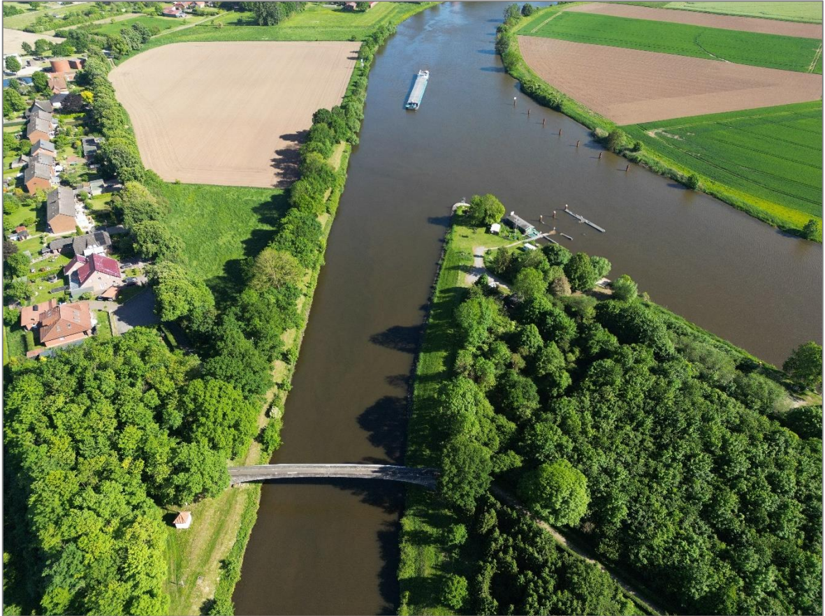
Abbildung 5 Blick auf den Einfahrtsbereich des Schleusenoberkanals.
