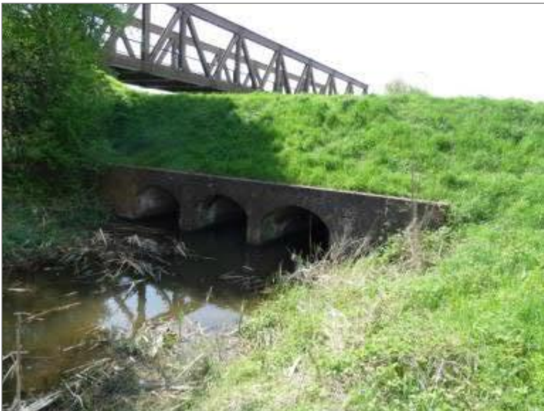
Abbildung 4 Graben, der sog. Kanal, bei der Brücke Nr. 54 (PÖYRY DEUTSCHLAND GMBH 2020b).
