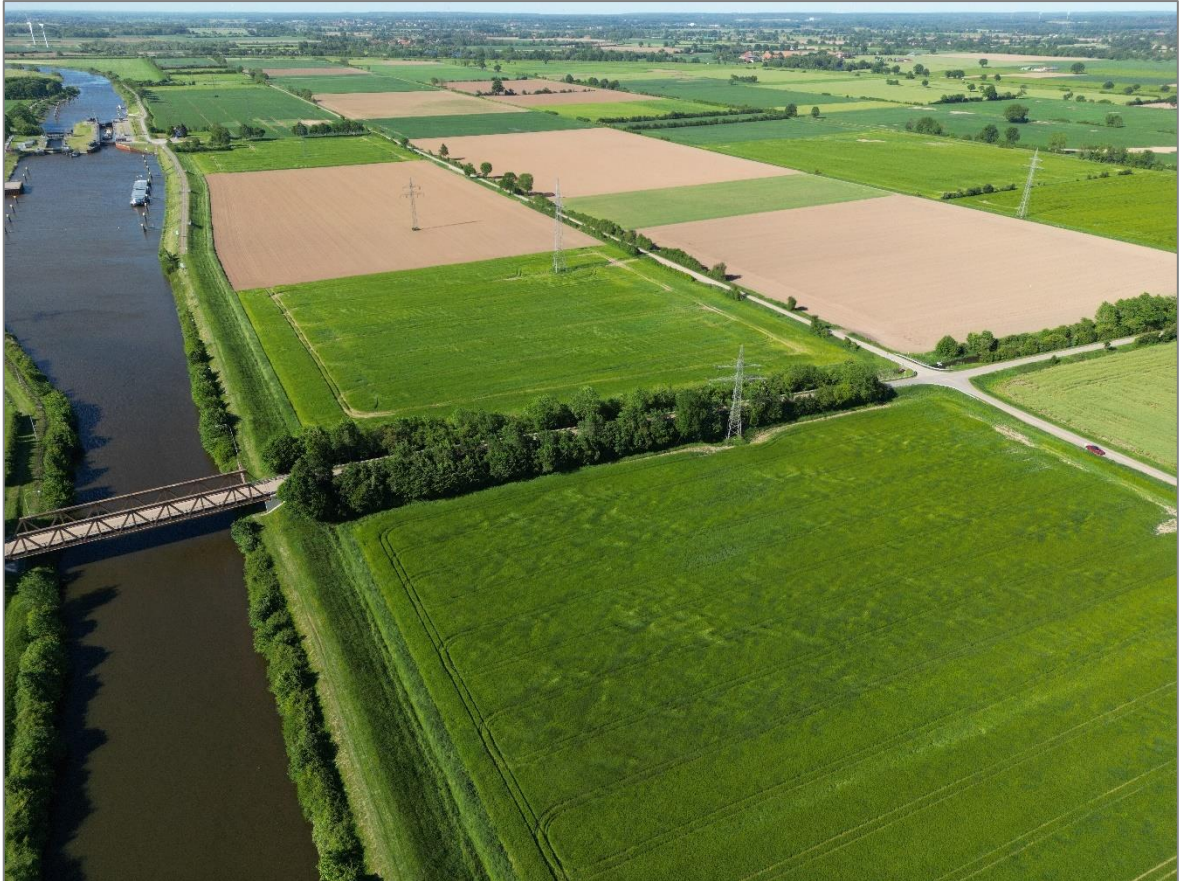
Abbildung 2 Blick auf die Brücke Nr. 54 Richtung Schleuse.
